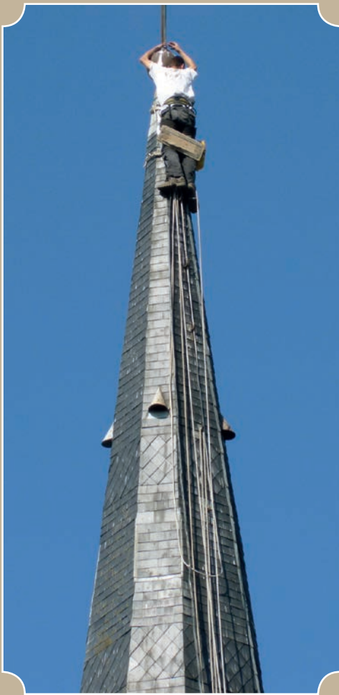
Mise en place d'un antifoudre sur le clocher de l'église (octobre 2013)
